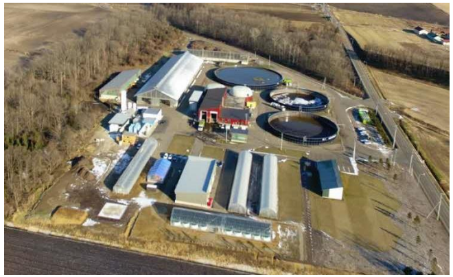
図9 中鹿追バイオガスプラントの状況
